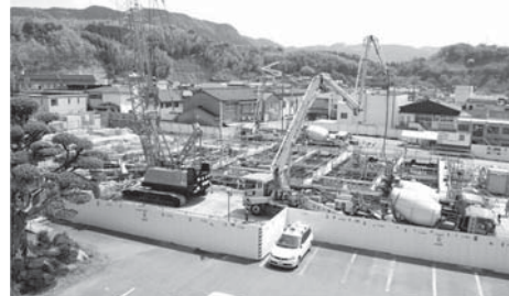
本体の基礎工事が始まった新庁舎建設
