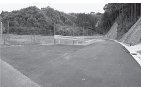
整備された農道と防護柵(柏原地内)
