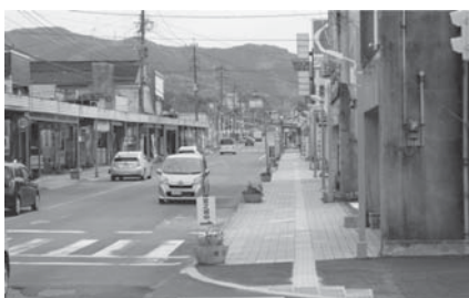
アーケードが撤去された商店街
