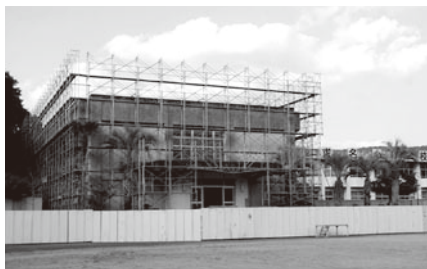
工事が始まった求名小学校屋内運動場
