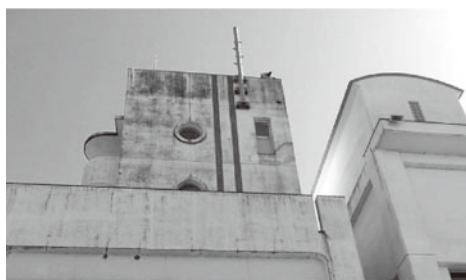
撤去が予定されている消防署の塔屋部分
