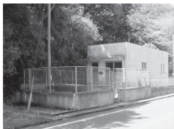
山崎簡易水道北原第2水源地
