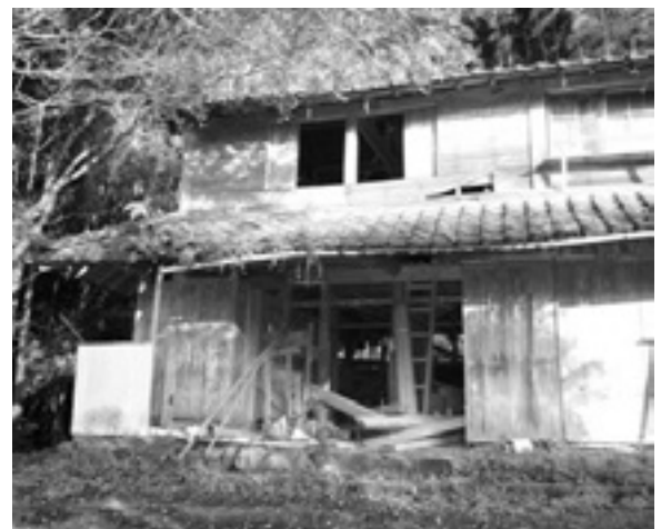
危険廃屋解体撤去事業により、解体撤去を計画している危険廃屋
