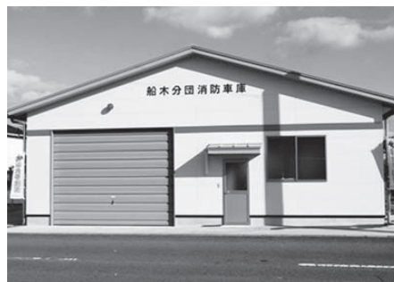
船木分団消防車庫の新築
