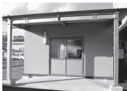
新庁舎印刷室(文書発送室)の新築
