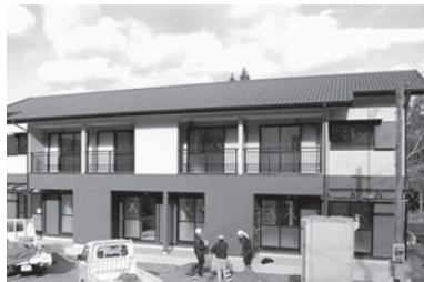
B棟の建築が進む山崎団地
