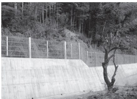
県単急傾斜地崩壊対策(木沢地区)
