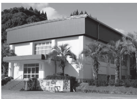
求名小屋内運動場耐震補強等
