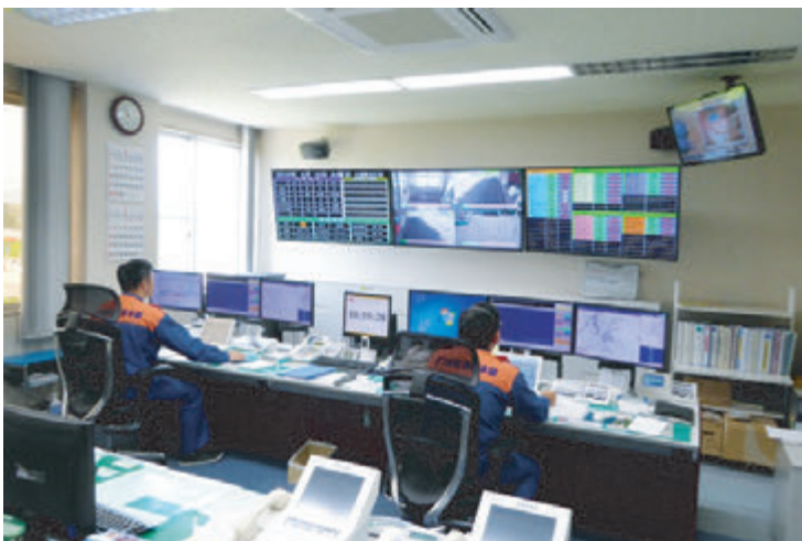
緊張感漂う通信指令室(さつま町消防本部)
