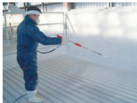
塗布している様子(上) ドロマイト石灰と機材(左)
