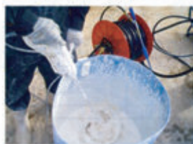
ドロマイト石灰 水に溶けやすく、発熱しない。 塗布後は剥がれにくい。
