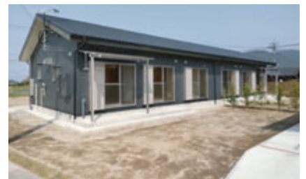
完成した「おしどり団地」
