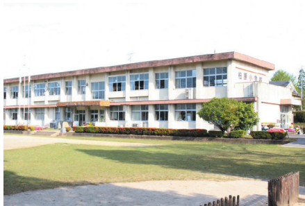
大規模改造工事を行う柏原小学校
