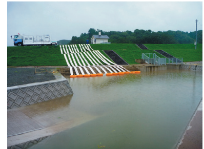
大雨時に配備されたポンプ車
