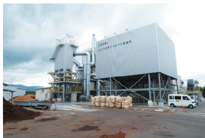
木質バイオマス発電を行っているさつま町バイオマス燃料合同会社
