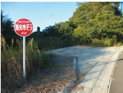
半地下式(埋設型)耐震性貯水槽
