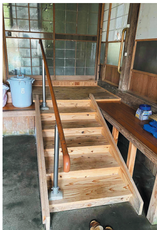
住宅改修で設置された手すり
