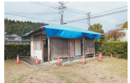
改修を行う若竹公園トイレ
