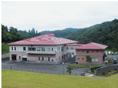
供用開始から 24 年が経過する環境センター
