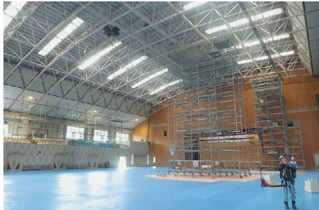
宮之城総合体育館メインアリーナ（照明の工事中）
