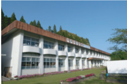
改造工事を行う薩摩小学校（旧中津川小学校）
