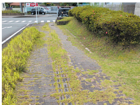
歩道及び誘導ブロック
