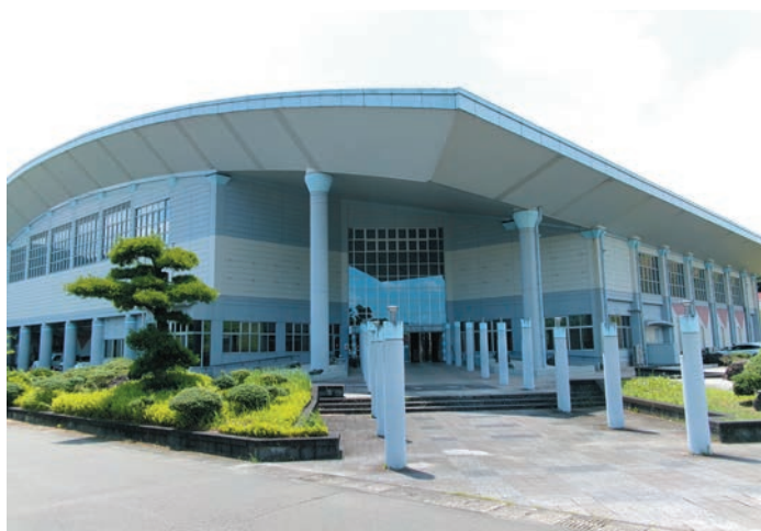
デマンド監視システムが導入されている 宮之城総合体育館
