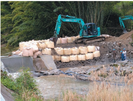
河川災害復旧工事
