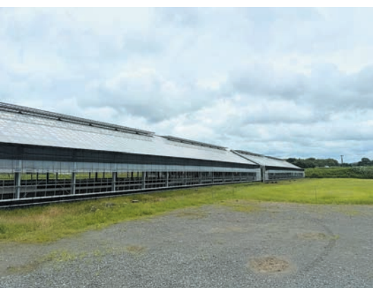
大規模なビニールハウス
