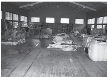
薩摩柔剣道場の物品の保管状況
