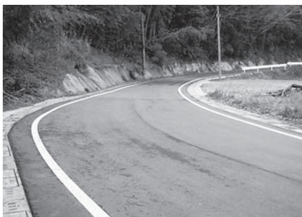
道整備交付金事業により整備が行われた戸子田熊田線（建設課）
