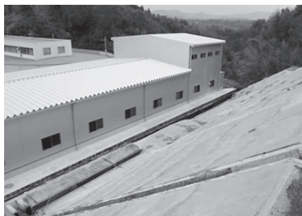
法面保護工事が行われた倉内工業団地（企業誘致対策室）
