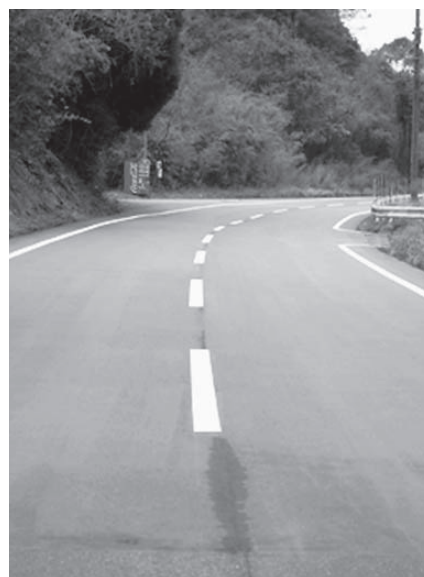
電源立地地域対策交付金を財源に路面整備が行われた紫尾区の町道「浦田線」
