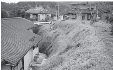
県単急傾斜地崩壊対策事業箇所(紫尾区)
