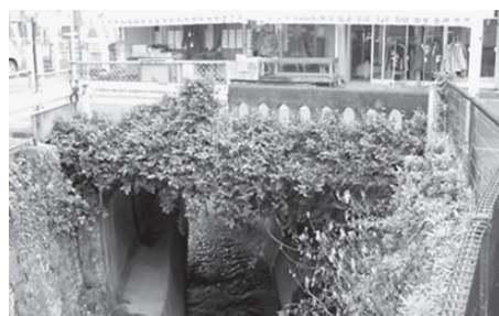
橋梁の改修が計画されている箇所
