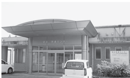
屋根等の改修工事が計画されている鶴田保健センター
