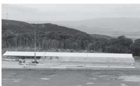
事業により整備が進む家畜飼養管理施設
