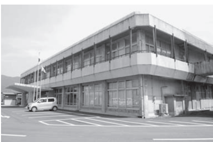
築42年が経過した文化センター事務所棟
