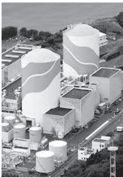
重要免震棟の建設が方針転換された川内原子力発電所(ネット画像より)
