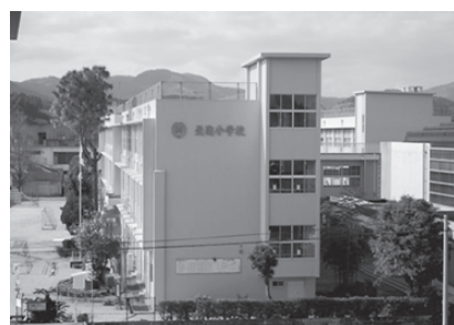
外壁の下地調整等補修が行われた盈進小学校校舎（教育総務課）
