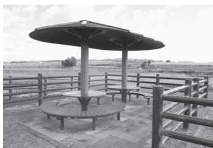
新たに設置された轟ノ上水辺公園の東屋（建設課）
