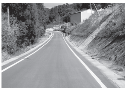
道整備交付金事業により整備が行われた町道「大保線」（建設課）
