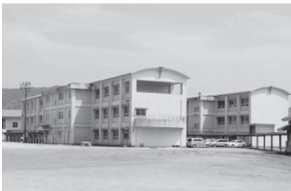
校庭側から撮影した宮之城中学校校舎
