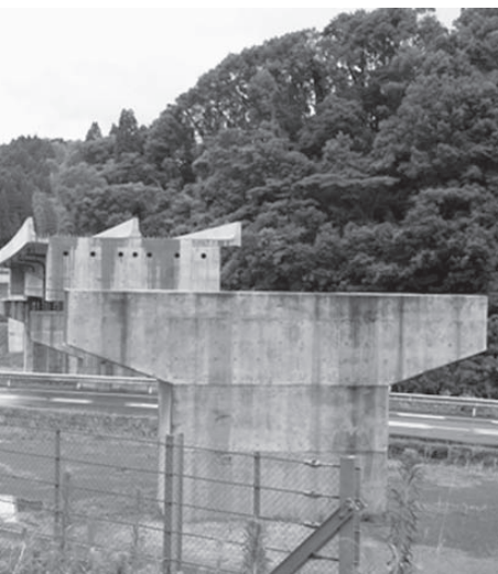
観光のアクセス道路として、早期完成が望まれる北薩横断道路（広瀬道路）の整備状況
