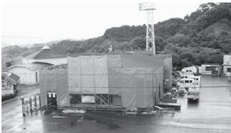
新築工事が進む大鶴ゆうゆう館
