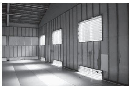
宮之城武道館の内壁の状況
