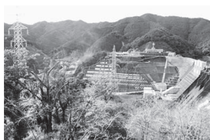
鶴田ダム公園内の支障木の状況
