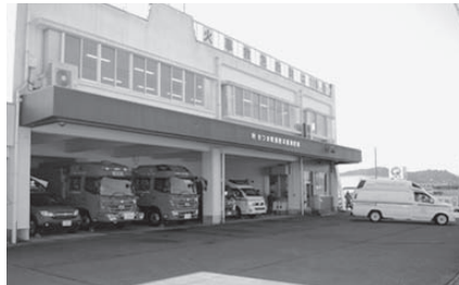
庁舎改修が行われた町消防本部庁舎（消防課）
