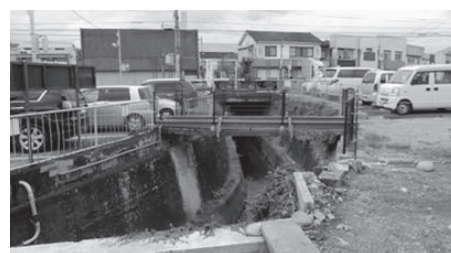
床版工による整備が予定されている豊川(宮之城屋地区)
