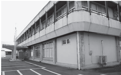
耐震補強が行われた宮之城文化センター事務所棟（社会教育課）
