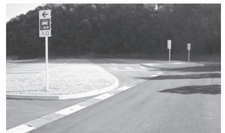
駐車場整備が行われた北薩広域公園の駐車場（建設課）
