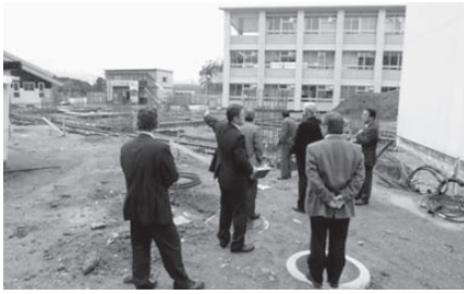
委員会による現地調査の状況
