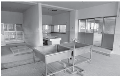
給食調理室を改修し厨房機器を整備
