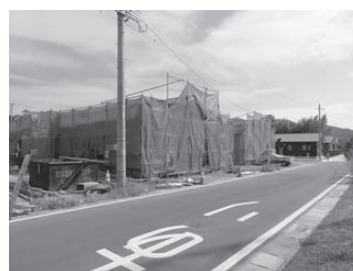
建設が進むおしどり団地
