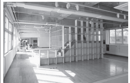
多目的スペースの改修状況
