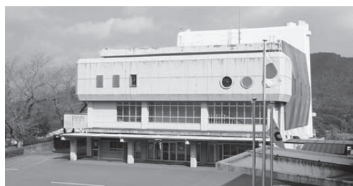
築45年経過している宮之城文化センター
