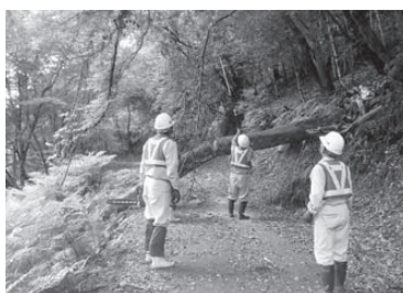
道路整備員による支障木の伐採作業
