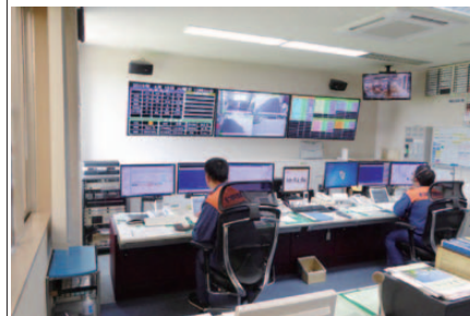
消防本部の要である消防指令室
