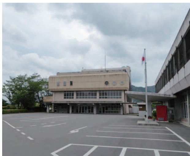
築45年経過している宮之城文化センター
