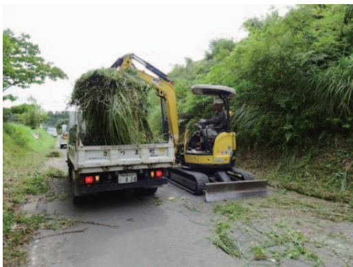
道路整備員による町道清掃作業
