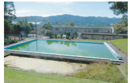
改修が行われる佐志小学校プール
