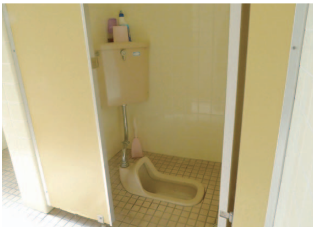
洋式トイレに改修される和式トイレ
