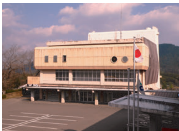
老朽化が進んでいる宮之城文化センター（築47年）
