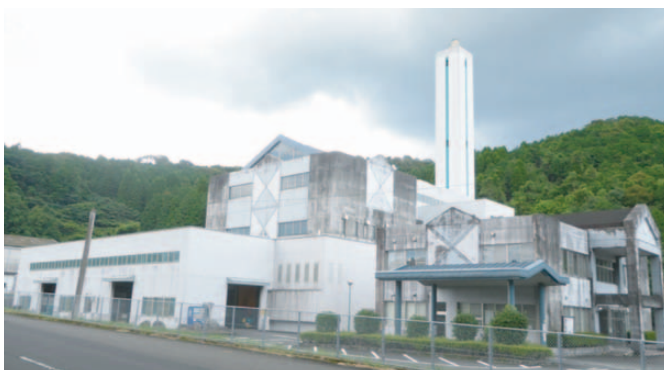
築24年が経過する、クリーンセンター
