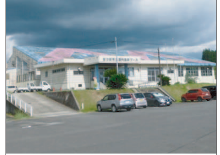
築32年経過し老朽化が目立つ
