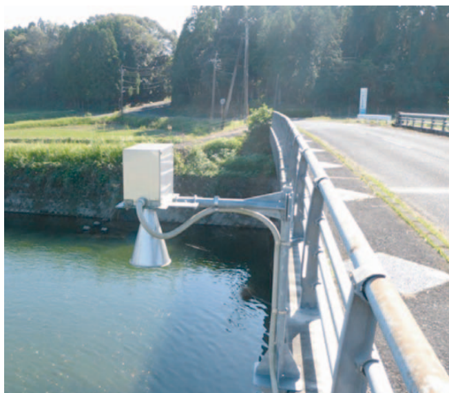
ほたる橋に設置された水位計（柏原地区）
