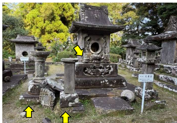
⑱T31・T32_燈籠損傷
