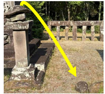
⑩T66_燈籠損傷状況
