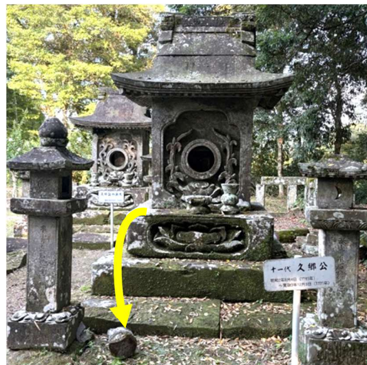
⑯B18_花立損傷狀況
