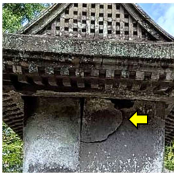
⑤B10_墓碑損傷状況
