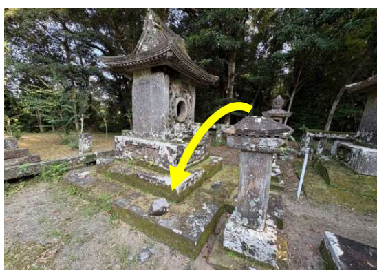
T61_燈籠損傷狀況
