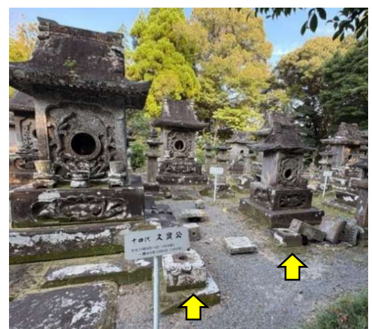
⑫T11・T12_燈籠損傷状況
