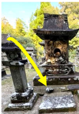
⑬T14_燈籠損傷狀況
