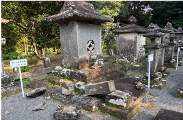
㉑T52_燈籠損傷状況
