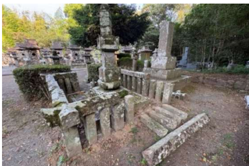
③B02_墓碑周囲の玉垣損傷状況
