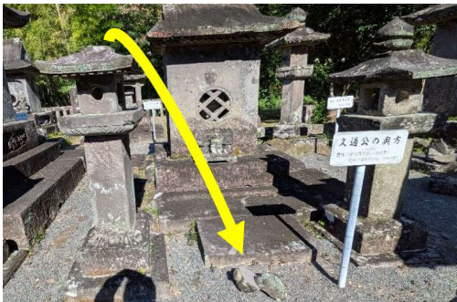
⑧T50_燈籠損傷状況
