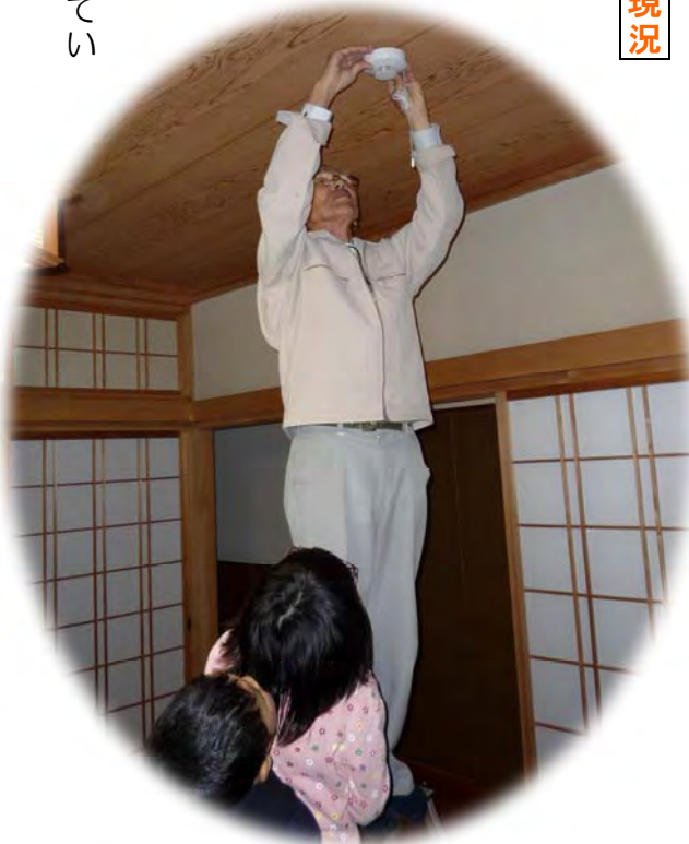
※ドライバー等の簡単な道具で取り付けできます。また、取り付けに特別な資格は必要ありません。
