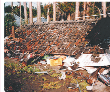
旧鶴田町空家倒壊
