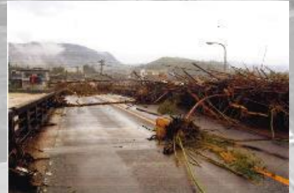
写真：平成18年7月 鹿児島県北部豪雨災害
