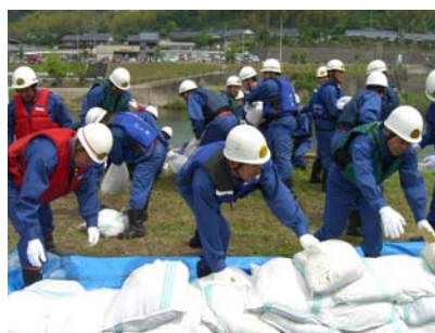
土のうを積み上げる消防団員
