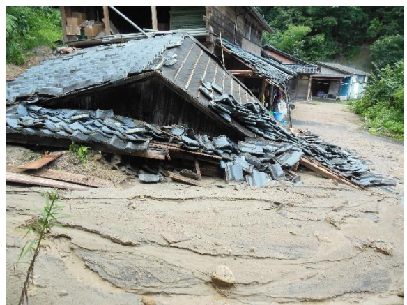
土砂流入により付属屋が被害
