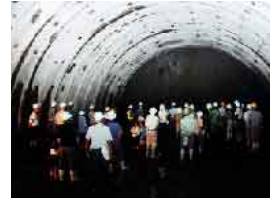
トンネルの中を見学する参加者
