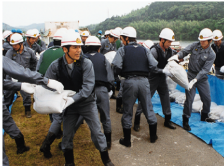
土のう積を行う本町水防団
