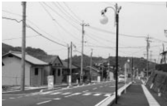
▶今回設置された街路灯
