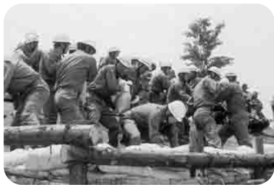
▲町消防団「築廻し工法」訓練の様子
