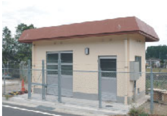
川口に新設された中継ポンプ場
