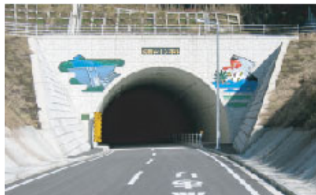
天狗山トンネル（中間側）
