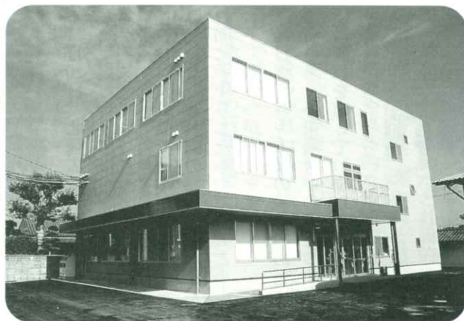
完成した庁舎東別館
