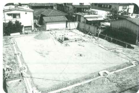
工事が進む庁舎東別館建設
