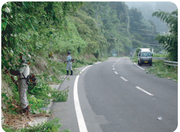
道路沿いの伐採作業
