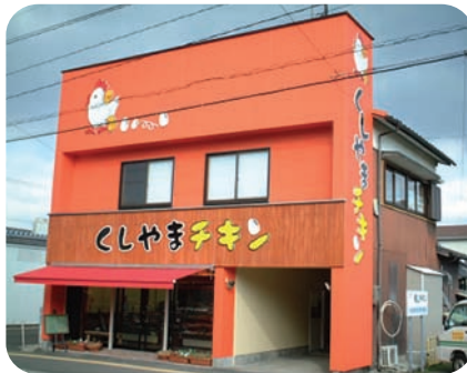
改装された店舗
