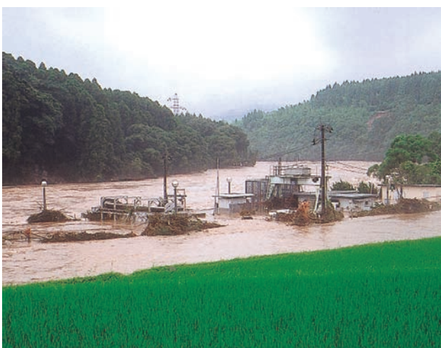
水没間近の神子発電所
