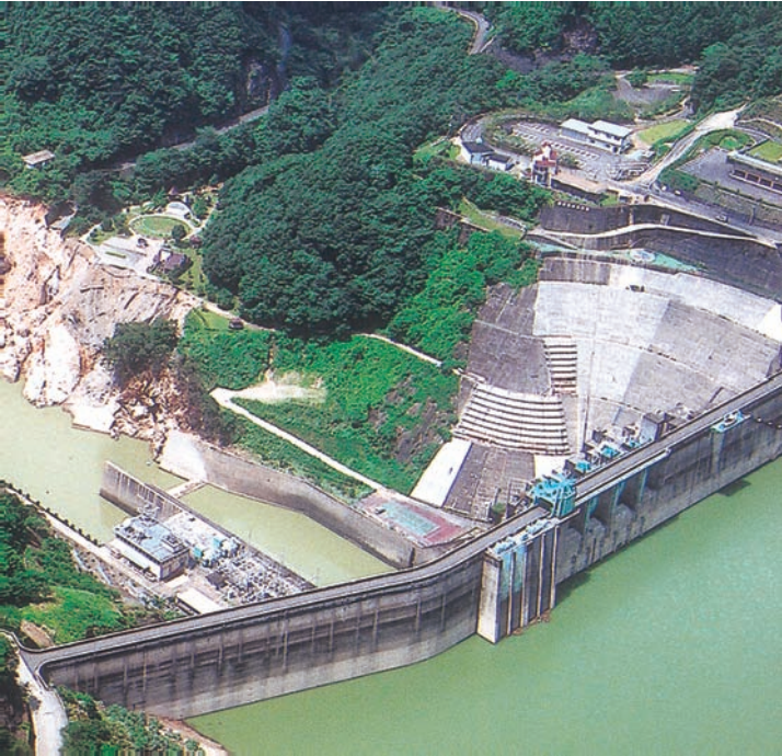
鶴田ダム下、右岸は崩れ、町道平江線は通行不能
