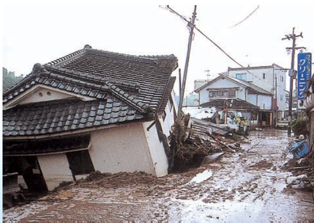
濁流にのまれ、倒壊した家屋（虎居町）
