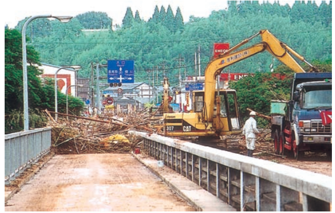
宮都大橋にかかった流木などの除去作業
