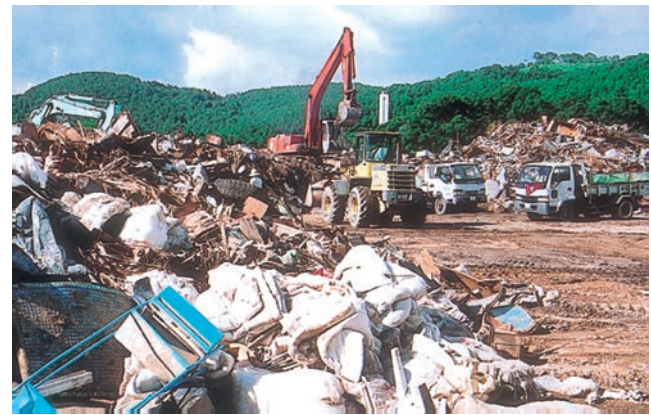
運ばれてきた大量の災害廃棄物の収集作業(倉内工業団地)
